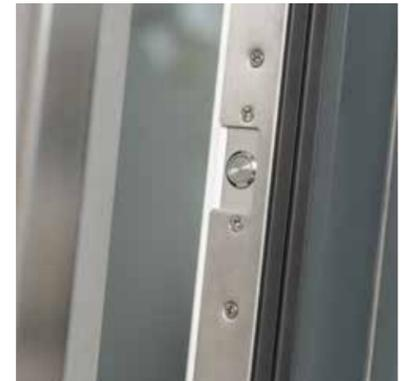
I-tec Open ist **vollständig in den Türrahmen integriert** und von außen nicht sichtbar.
